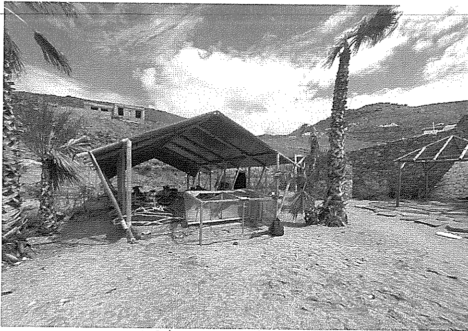
Αυθαίρετη κατασκευή με αρ. (15)
