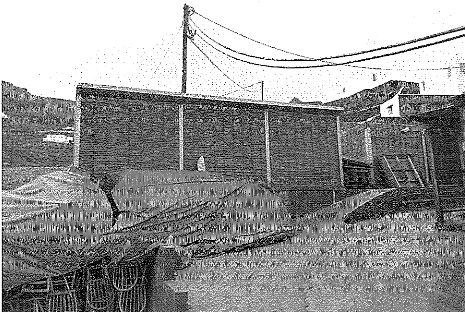
Αυθαίρετη κατασκευή με αρ. (3)
