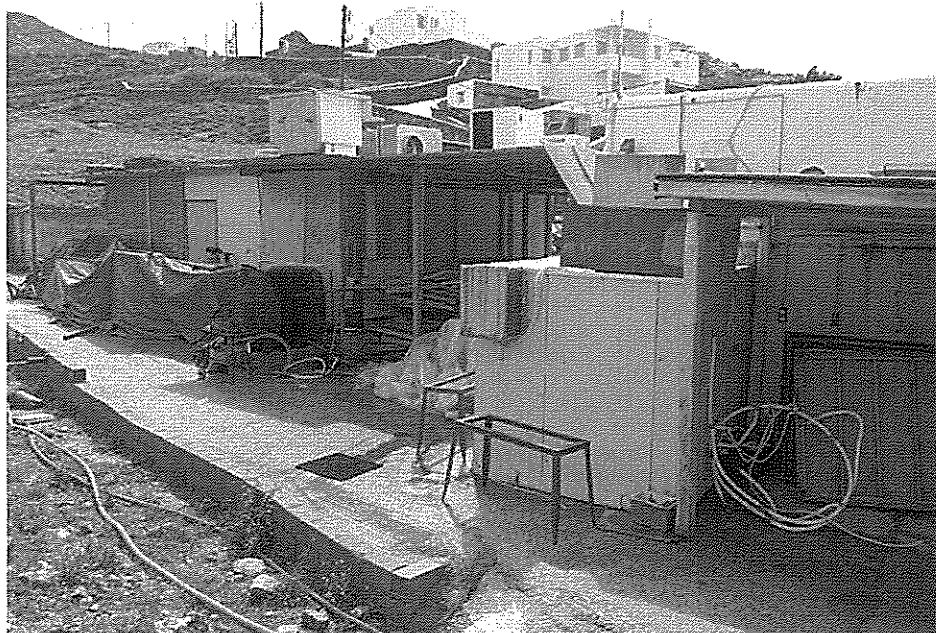
Αυθαίρετες κατασκευές με αρ. (11),(10) και (12) στην αριστερή πλευρά και (12), (13) και (9) στη δεξιά
