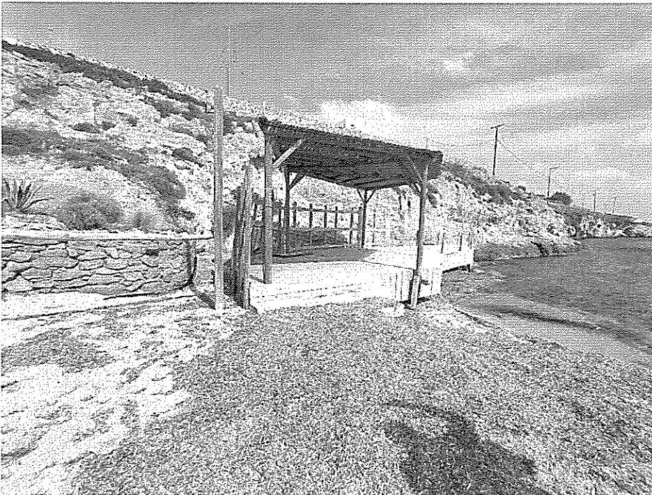
Αυθαίρετη κατασκευή με αρ. (9)
