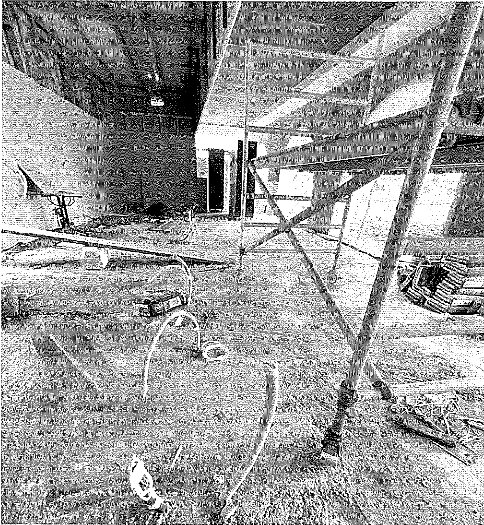
Εσωτερική άποψη κτιρίου 1
