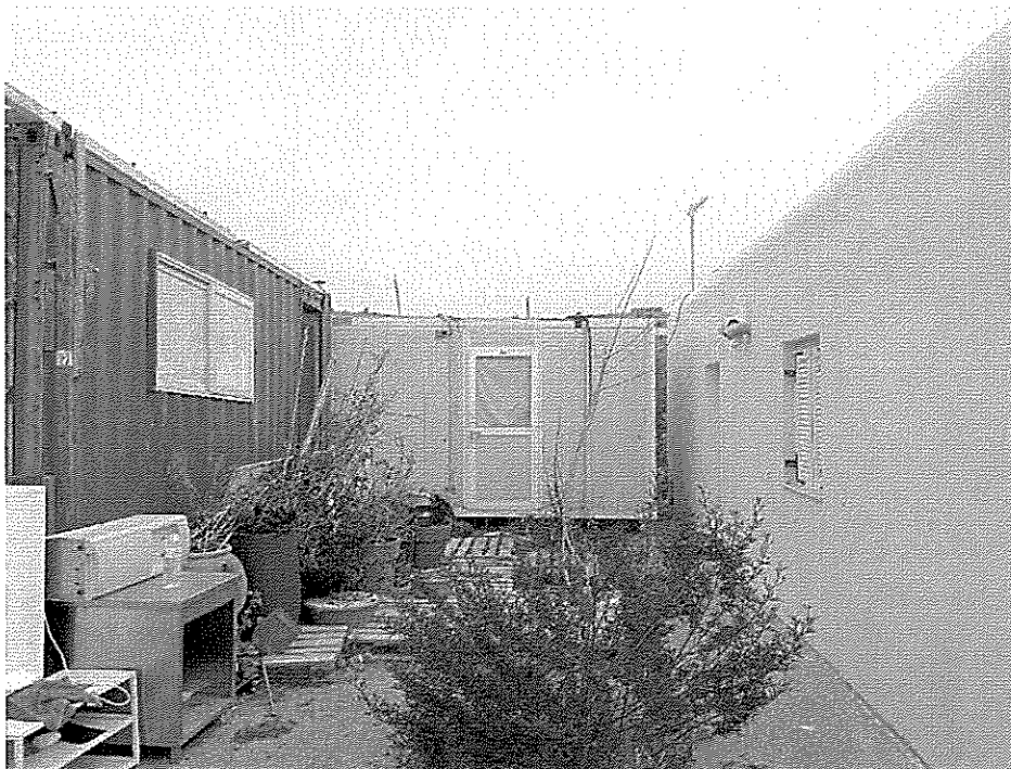
Αυθαίρετη κατασκευή με αρ. (6), (3) και (7).
