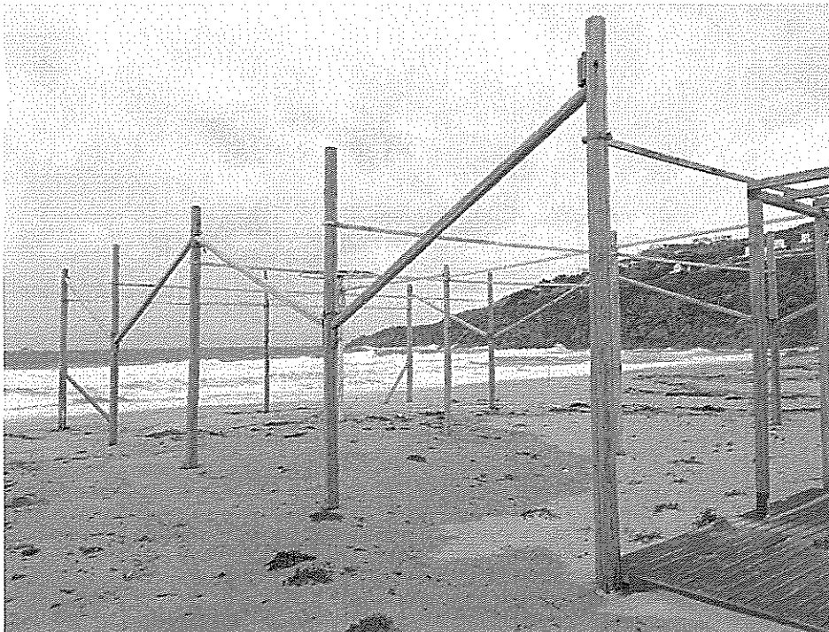
Κατασκευή στον αιγιαλό εμπροσθεν του με αρ. (15)
