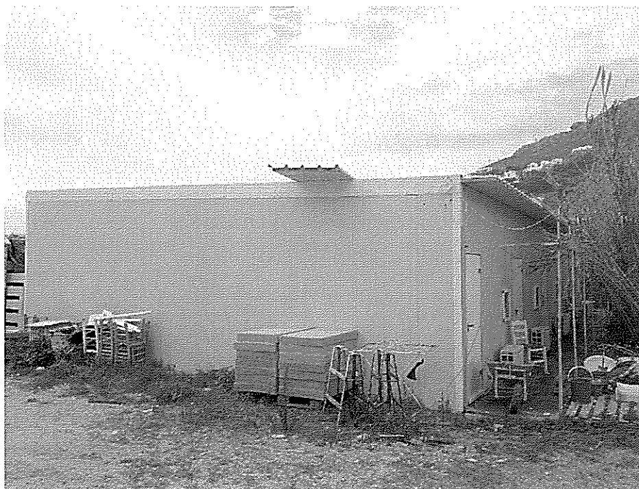
Αυθαίρετη κατασκευή με αρ. (4)
