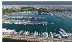
5 ΜΑΡΙΝΑ ΑΛΙΜΟΥ Μαρίνα (υπο κατασκευή)
