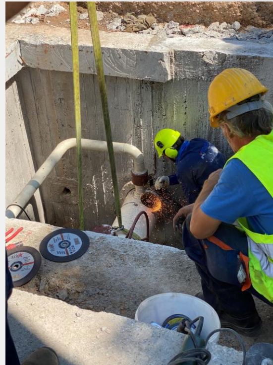
Κοπή των άκρων και αφαίρεση της Βάνας
