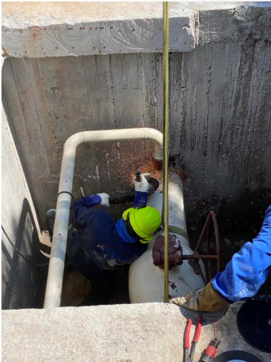
Κοπή των άκρων και αφαίρεση της Βάνας
